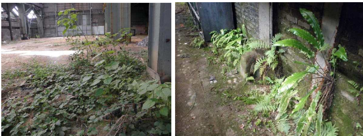
Photo 2 : Colonisation par la végétation des espaces internes aux bâtiments
