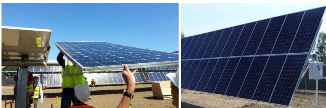
Photographie II.7-1 : Mise en place des panneaux photovoltaïques – Source : Total Solar
