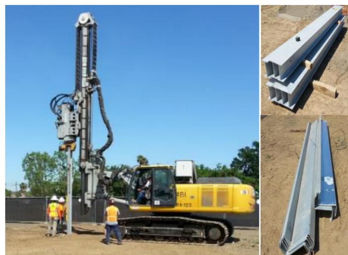
Photographie II.9-II : Mise en place de pieux battus au sol pour ancrage des structures
