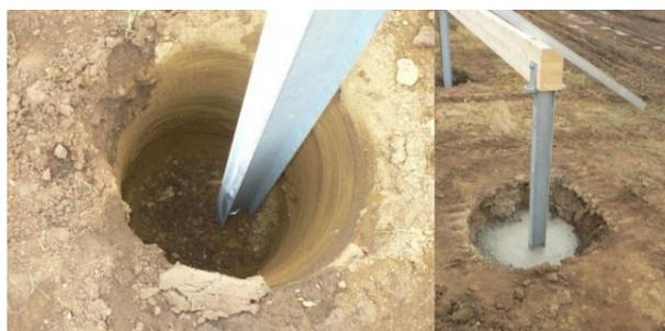
Photographie II.9-I : Réalisation de fondations béton superficielles pour ancrage des structures
