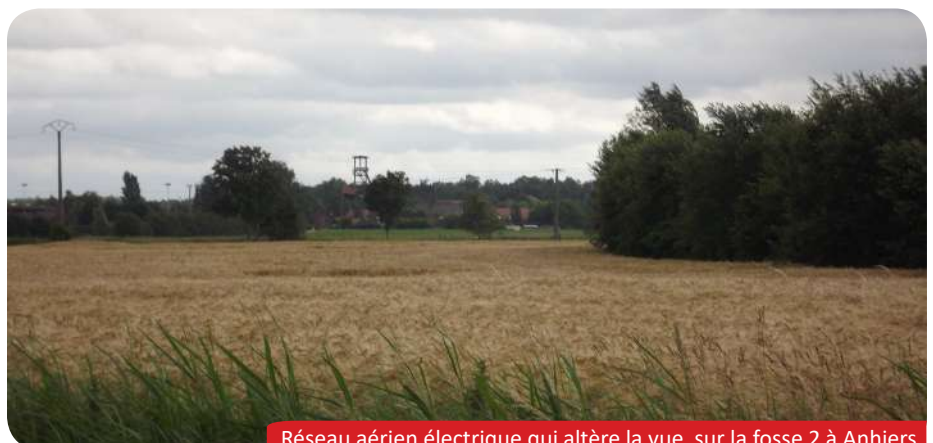
Réseau aérien électrique qui altère la vue sur la fosse 2 à Anhiers
