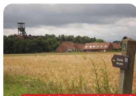
Vue sur le chevalement de la Fosse 2 depuis le «circuit des deux ponts»
