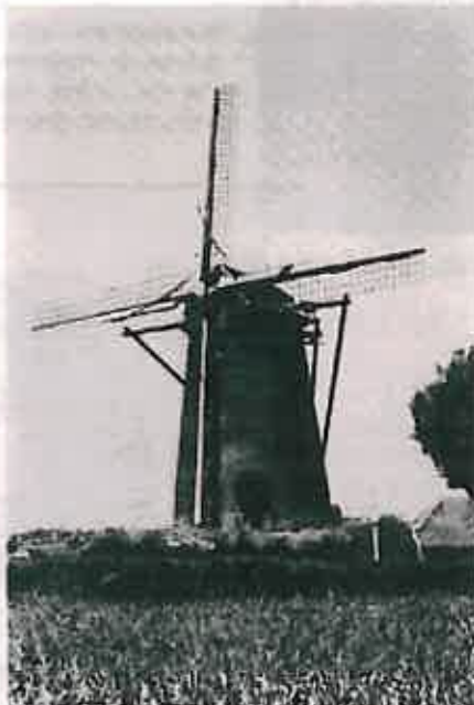
TERDEGHEM : Vue arrière de la calotte tournante reliée à la queue du moulin.
