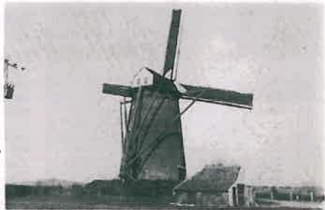
TERDEGHEM : Vue arrière de la calotte tournante reliée à la queue du moulin.
