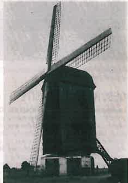
TERDEGHEM : Vue arrière de la calotte tournante reliée à la queue du moulin.
