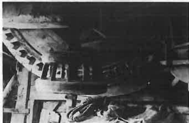
HOUTKERQUE, mécanisme interne du moulin de l'Holland. Vue du système de transmission : la lanterne.
