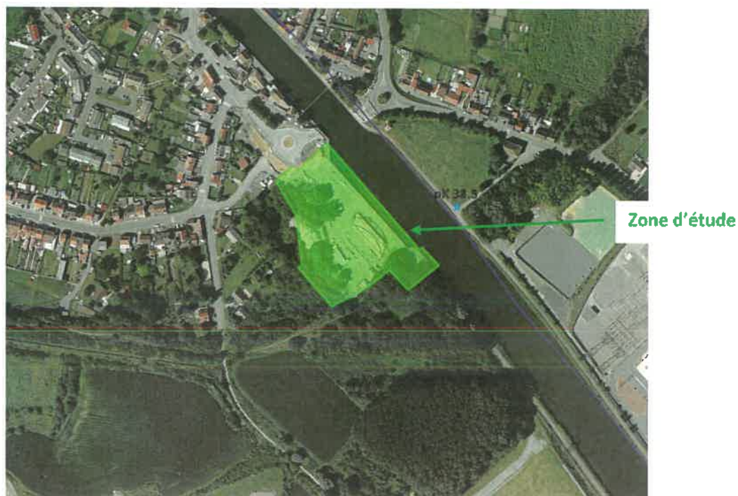
Figure 2 : Vue aérienne de la zone d'étude
