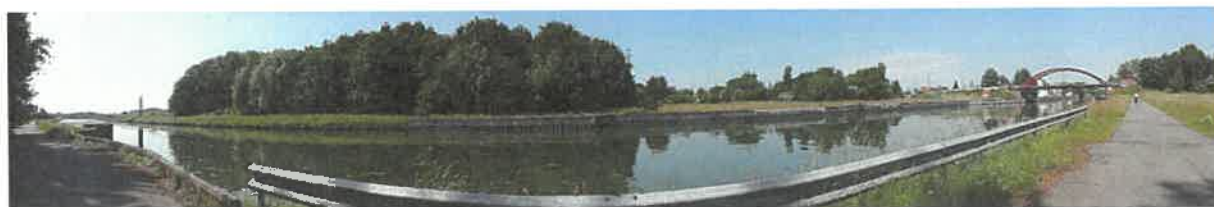
Figure 8 - Vue générale du site
