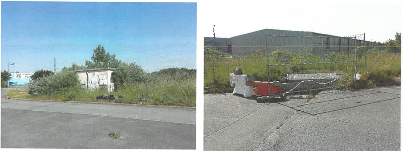
Figure 13 – Poste Electrique et réseaux à proximité
