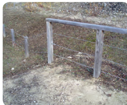
Garde-corps en bois et métal, G. Lemoine
