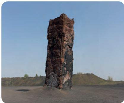
Terril 101 : vestige mis à jour par l'exploitation d'un pied de téléphérique dans lequel s'est accumulé et compressé du schiste. Mission Bassin Minier
