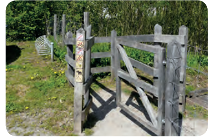
Autre système de barrière sélective incluant un rappel des réglementations. Un parking vélo est prévu. Mission Bassin Minier
