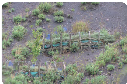
Fascinage sur une pente, BM
