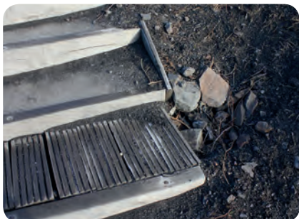
Intégration d'une gouttière dans un escalier pour évacuer l'eau lors d'un changement de pente, Mission Bassin Minier
