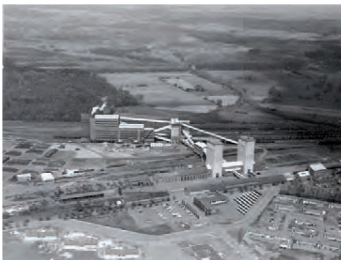
Le siège Barrois avec ses deux tours de concentration en 1965. A l'arrière plan, le terril 143a et le bassin de décantation. © CHM
