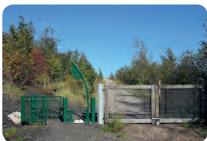
Association d'une barrière sélective PMR, d'un pass'vélo et d'un portail bloquant les 2 roues motorisées, S. Dhote
