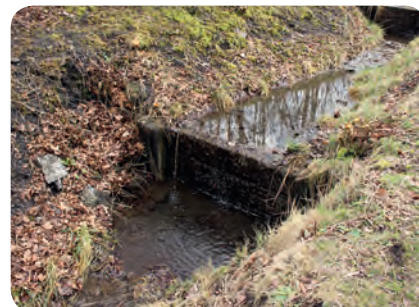
Une succession de palplanches bois ralentissent l'eau en parallèle d'un cheminement, Mission Bassin Minier
