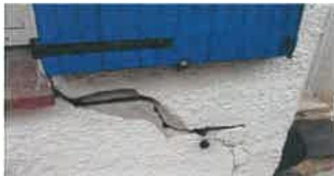
Le phénomène de retrait-gonflement se manifeste par des mouvements différentiels qui se concentrent à proximité des murs porteurs, tout particulièrement aux angles d'une construction. Il peut engendrer des dommages importants sur les bâtiments et même compromettre la solidité de l'ouvrage: fissures ou lézardes des murs et cloisons, affaissement du dallage, ruptures de canalisation enterrée.
