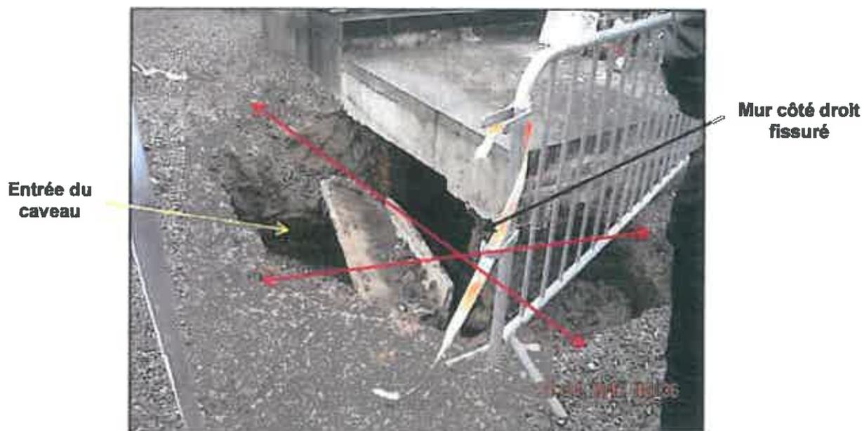
Figure 5 : Vue générale du mouvement de terrain
