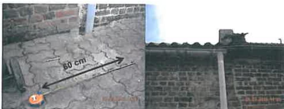
Figure 14 : Aperçu de l'affaissement au droit de l'évacuation des eaux de pluie
