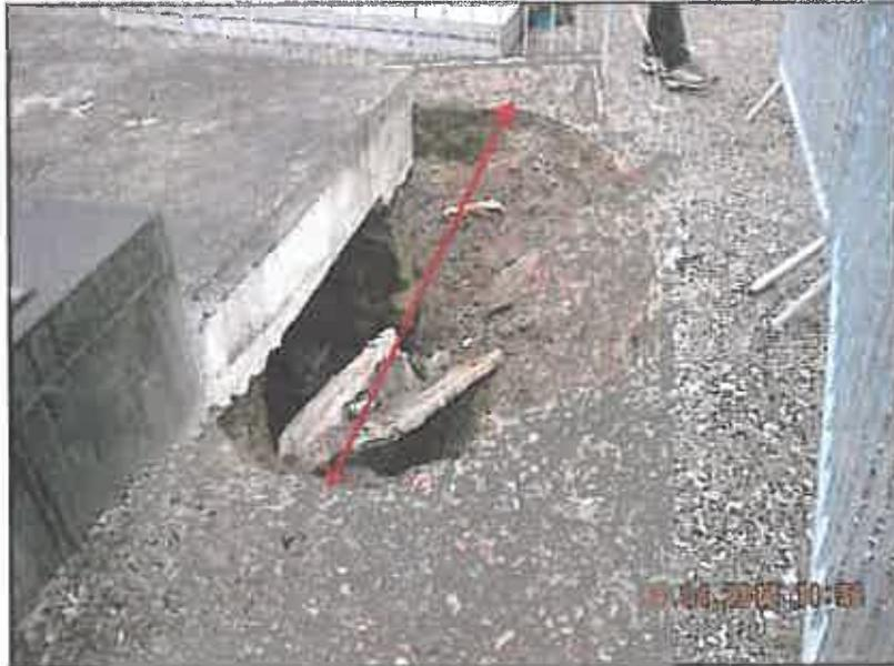
**Figure 6 : Autre vue du mouvement de terrain**
