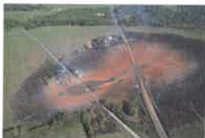
Conséquences d'une fuite sur une canalisation de transport, Appomatox (USA), 14 septembre 2008 (source pstrust.org).
