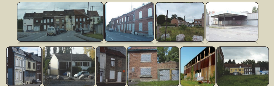
Figure 14. Divers bâti acquis, restant à acquérir ou déjà démolit.
