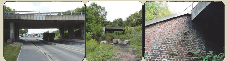
Figure 12. A gauche : l'ouvrage à démolir sur la RD75 ; Milieu et droite : l'OA n°7 est un ouvrage existant et réutilisé.
