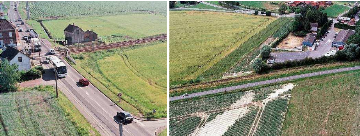
Passage à niveau de la RD945 au nord et ligne ferroviaire de marchandise au sud
