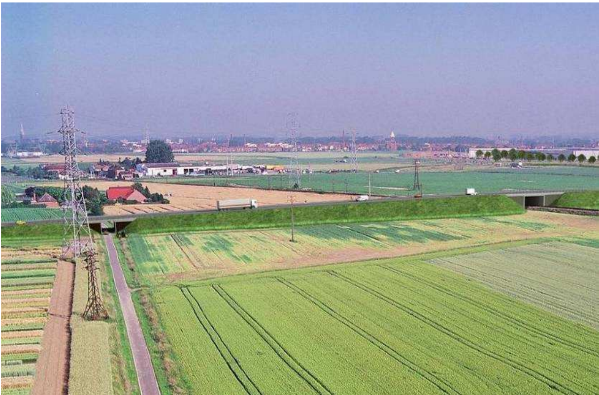
Traversée du chemin de Cortembut et de la voie de chemin de fer
