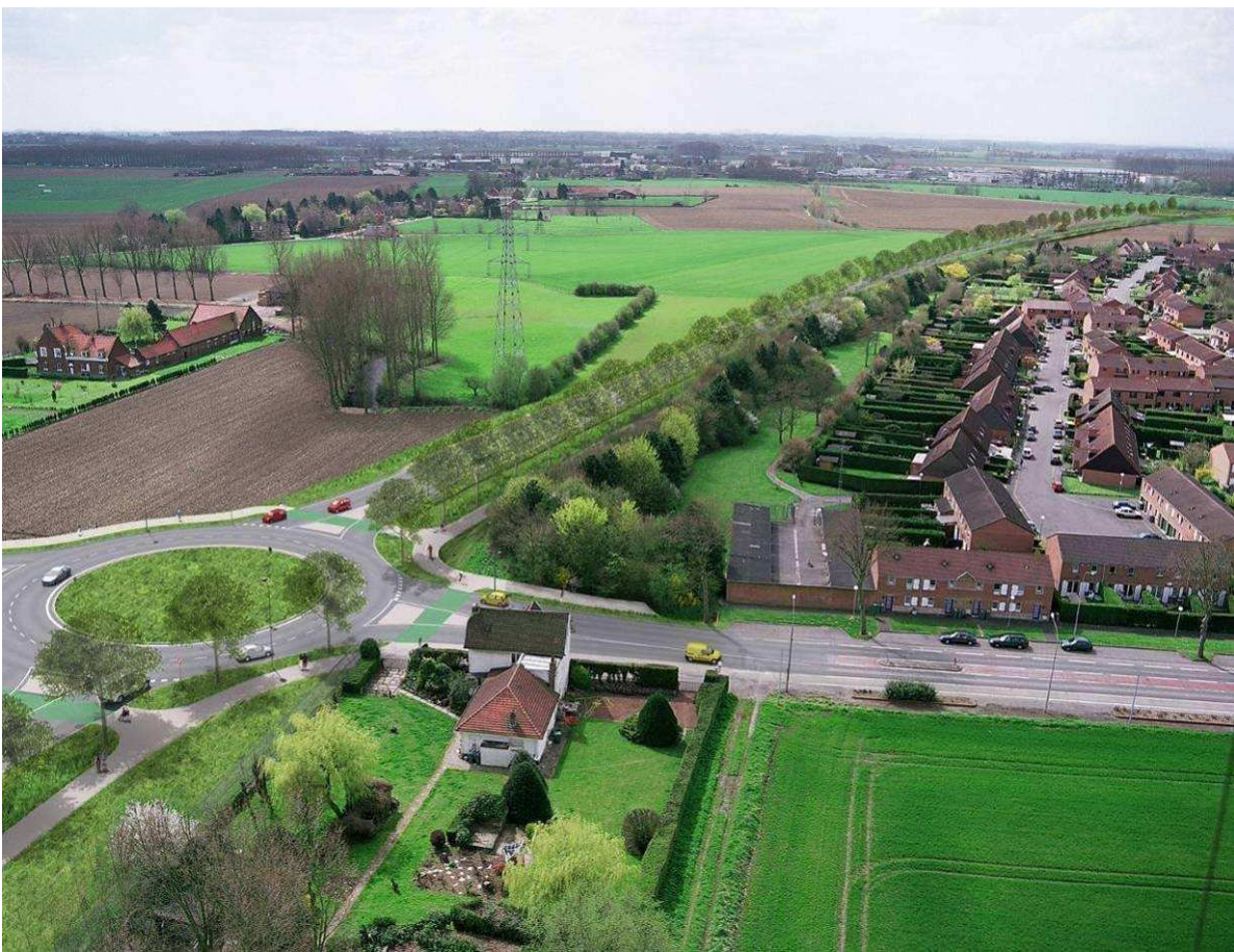
Giratoire entre la nouvelle voirie et la route Nationale (RD933)
