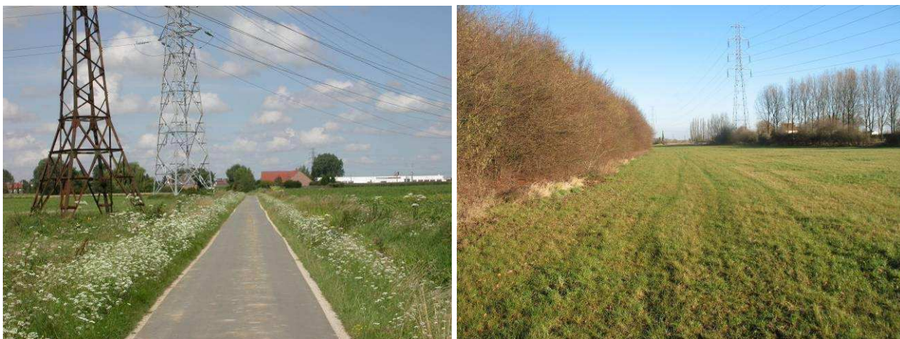
Ligne Très Haute Tension traversant le territoire
