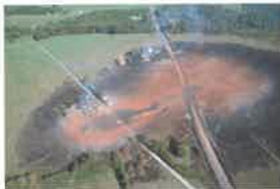
Conséquences d'une fuite sur une canalisation de transport, Appomattox (USA), 14 septembre 2008 (source pstrust.org ).
