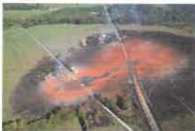
Conséquences d'une fuite sur une canalisation de transport, Appomattox (USA), 14 septembre 2008 (source cultus.org).
