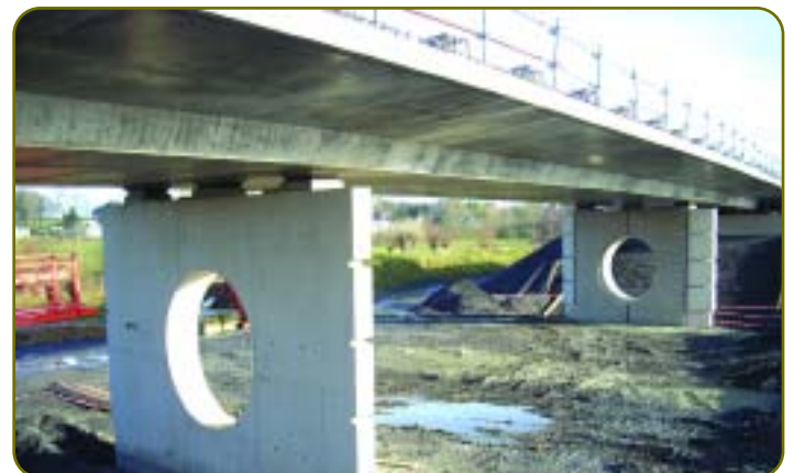
Rétablissement de voirie sur la RN 2 entre Maubeuge et Avesnes © DIRN – service d’ingénierie routier secteur Ouest
