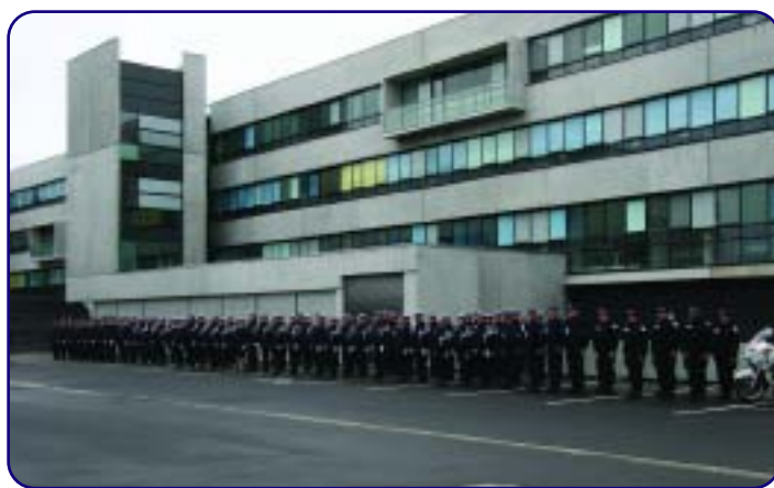
Nouvel hôtel de police de Lille - © Préfecture - BCI
