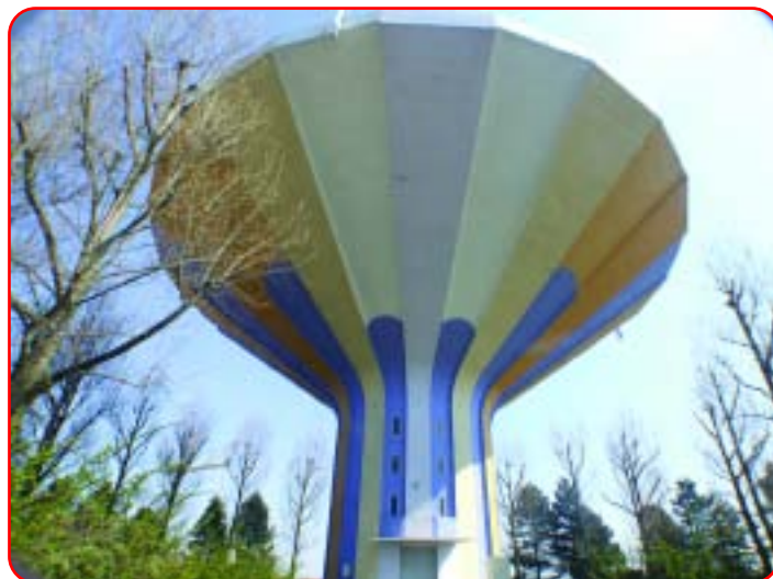
Réservoir d'eau - T.Vallois - © DDASS 59
