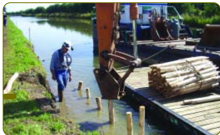
Boudins de coco pré-plantés sur des pieux en bois © Service navigation Nord – Pas-de-Calais / Voies navigables de France
