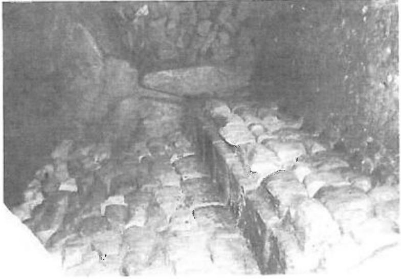
Toujours à Rumilly. Ici, le mur de séparation entre deux cellules a été épaisi dans sa partie inférieure. On remarquera la rigole creusée dans la rangée de pierres supérieure, ainsi que l'encoche, dans la paroi du fond. Il semble bien s'agir d'une mangeoire, initialement équipée d'un râtelier.
