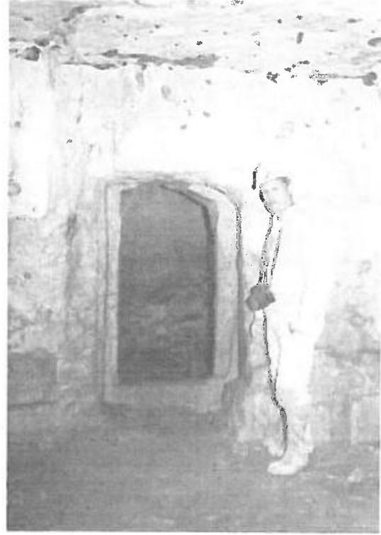
Ici, point besoin de mur de séparation érigé au moyen de blocs. Une chambre a bel et bien été creusée dans un massif laissé vierge par les carriers. On y accède par une ouverture découpée dans une paroi de faible épaisseur. Une porte en bois permettant d'isoler la chambre de la rue.
