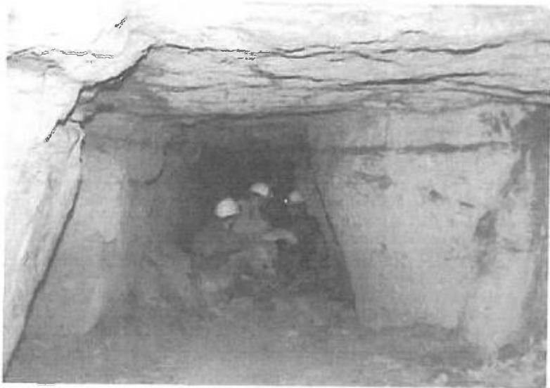
Dans la carrière de la Place, à Waincourt, les piliers sont généralement bien découpés et bien alignés. L'ouvrage est pourtant fragile. Un effondrement a déjà détruit une maison, en 1984, et des travaux de consolidation s'avèrent nécessaires sous la route.
