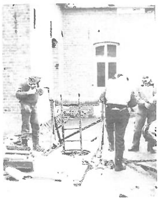
Les carrières de Villers-Outréaux ne sont quasiment pas accessibles sans appareils respiratoires, en raison du faible taux en oxygène, et de la présence d'une teneur élevée de gaz carbonique.
