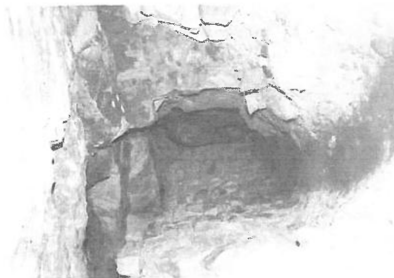
A Walincourt, dans la carrière « Longlet », un chemin a dû être tracé au travers des remblais et des éboulis, qu'un mur de parpaings retient latéralement.
