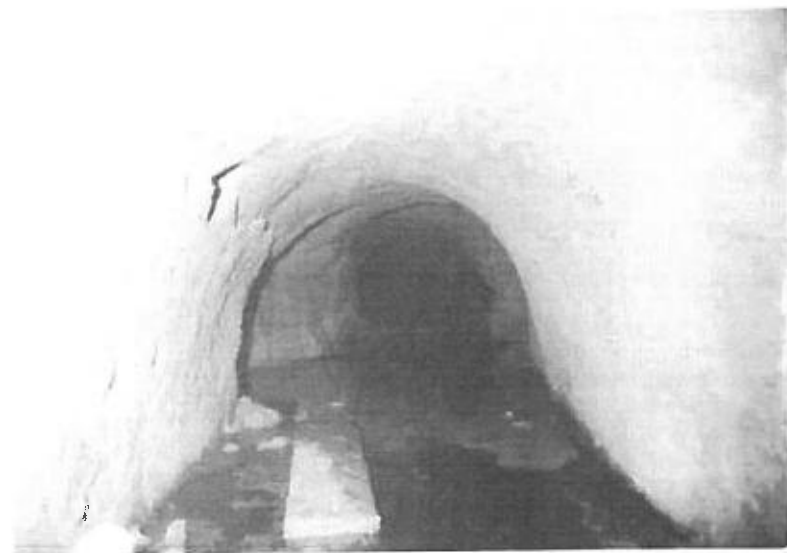
Vue intérieure du premier souterrain-refuge de Flesquières, au moment du remblayage. On remarquera l'absence de tout soutènement dans cet ouvrage peu profond, creusé dans les limons.
