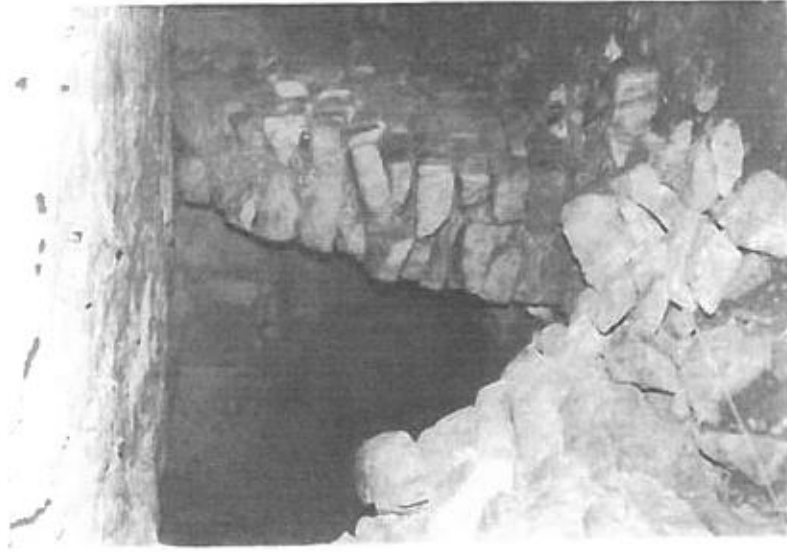
A Rumilly encore, les réfugiés se sont installés dans des cellules constituées par les piliers de l'exploitation et des murs de moellons de craie dans lesquels ont été aménagées les ouvertures donnant sur un couloir.
