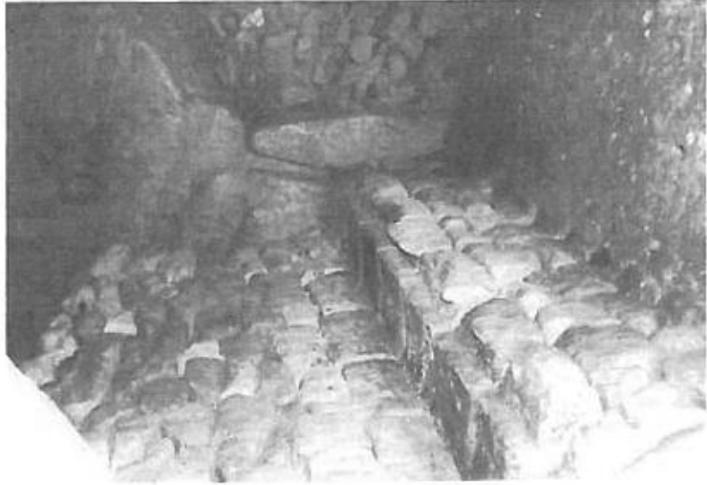
Toujours à Rumilly. Ici, le mur de séparation entre deux cellules a été épaissi dans sa partie inférieure. On remarquera la rigole creusée dans la rangée de pierres supérieure, ainsi que l'encoche, dans la paroi du fond. Il semble bien s'agir d'une mangeoire, initialement équipée d'un râtelier.
