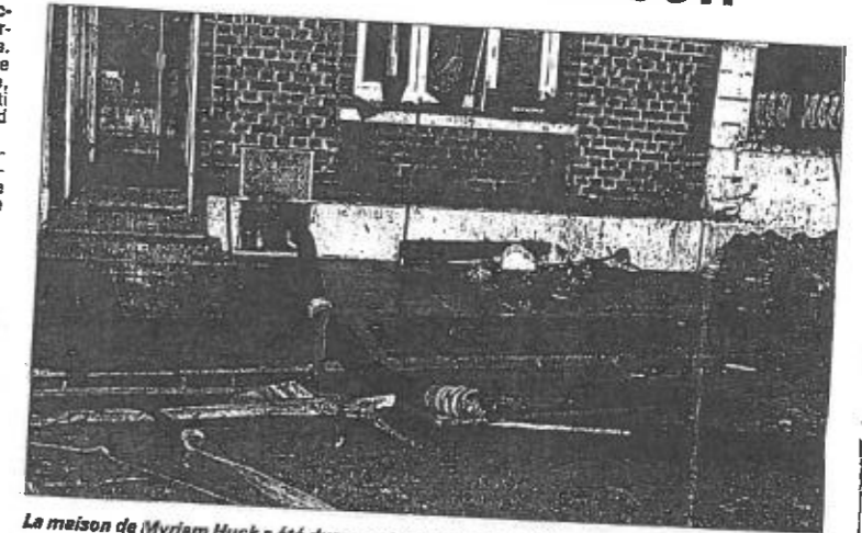
La maison de Myriam Huck a été durement touchée. L'habitation des Mésasse, au n°11, connaît des infiltrations mais a été dans l'ensemble épargnée car située différemment.
