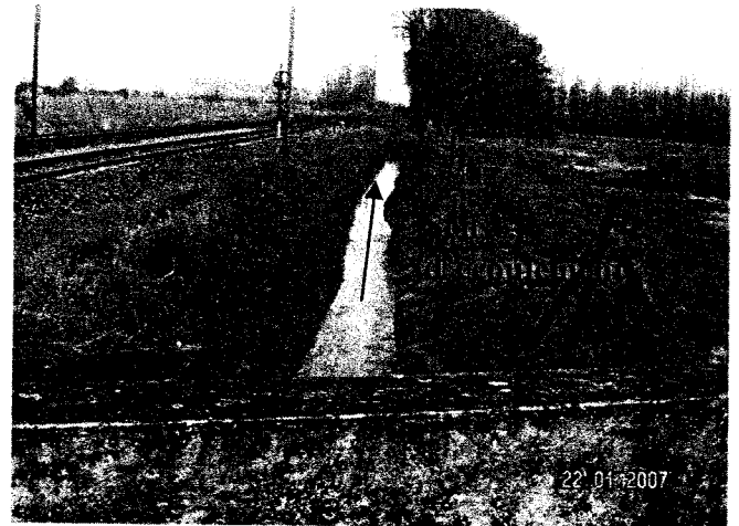
4. Exutoire fossé terre côté VP2
