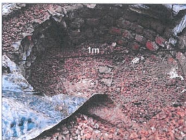
Illustration 6 : vue après déblaiement : apparition des parois d'un puits
