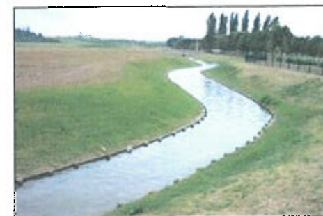
Bassin de rétention de type « cours d'eau » – photo non contractuelle
