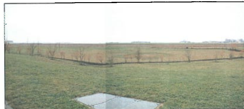
Bassin de rétention « sec » paysager – photo non contractuelle
