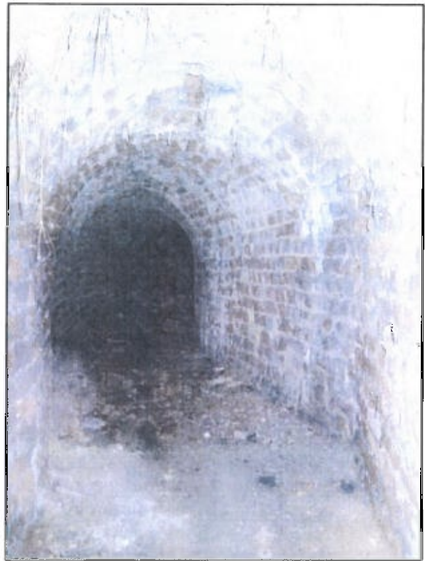
Figure 5 : Galerie avant traitement (DOE)
