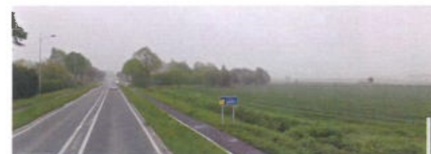
Limite du secteur Sud d'étude, le long de la D13 à proximité du bassin de rétention
